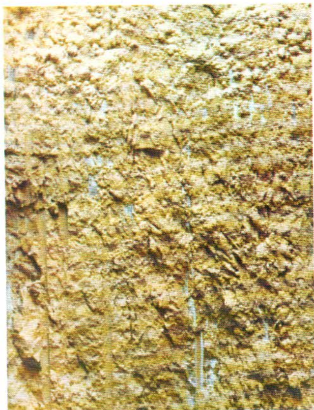
foto 31 - La parete dello scavo veniva rivestita con uno strato coibente di poliuretano espanso visibile sulla foto, di colore giallo. Il ghiaccio tende a trasparire.
