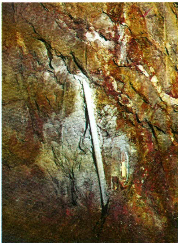
foto 25 - L'unica sonda congelatrice deviata a 26.00 m di profondità, messa a nudo durante lo scavo. Sulla destra si nota una spaccatura della roccia con materiale fine congelato ed in parte impregnato con resina.
