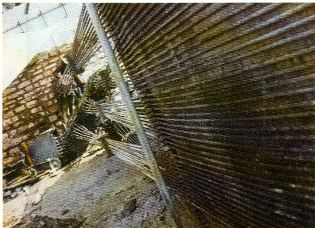
foto 14 - I 60 trefoli degli ancoraggi orizzontali avvolgono la testata della pila, disposti su una cuffia metallica e distanziati da una serie di pettini.
