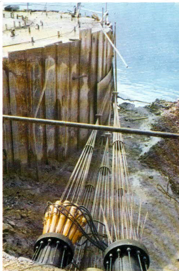
foto 15 - Piastre di aggancio dei trefoli e 24 trefoli appartenenti a 2 tiranti omologhi. Fase di tesatura contemporanea di due tiranti.
