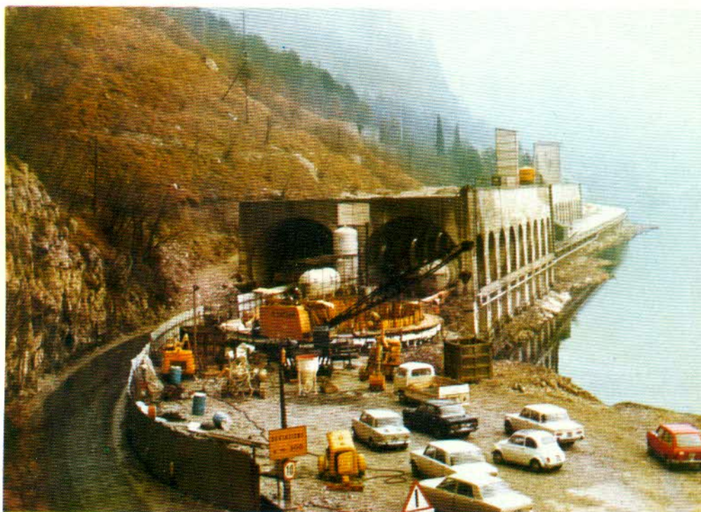
foto 1 - Vista panoramica del cantiere, presa dalla parete del monte Borbino verso Lecco.
