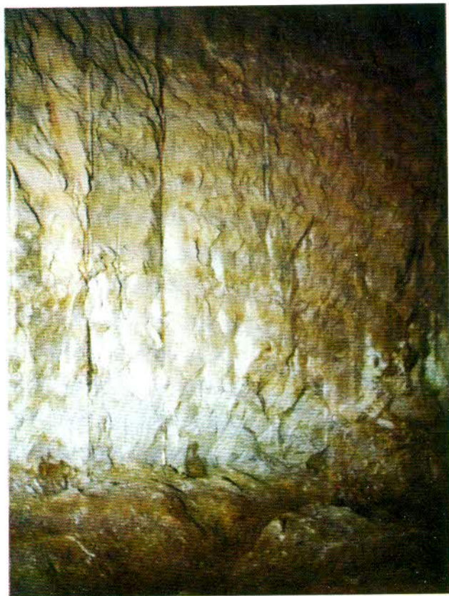
foto 32 - Scavo dell'incastro nella roccia. In alto si può notare la zona di contatto con il detrito di falda; sul fondo una grossa spaccatura completamente asciutta malgrado il notevole carico idraulico. Si notano anche alcune tracce di fori di "presplitting".
