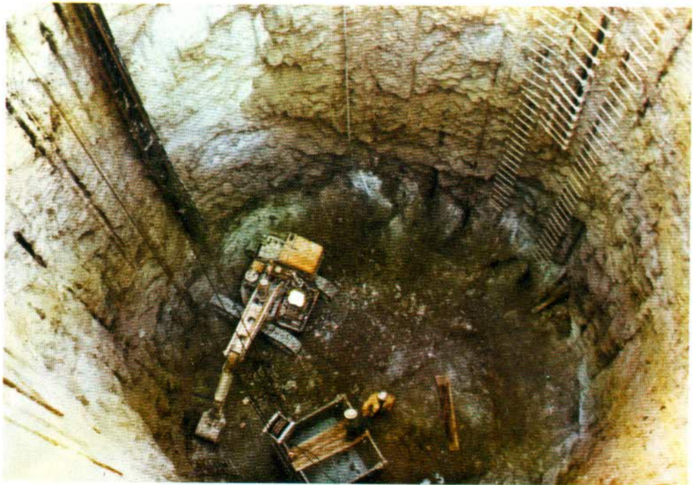
foto 30 - Scavo in fase di esecuzione.
