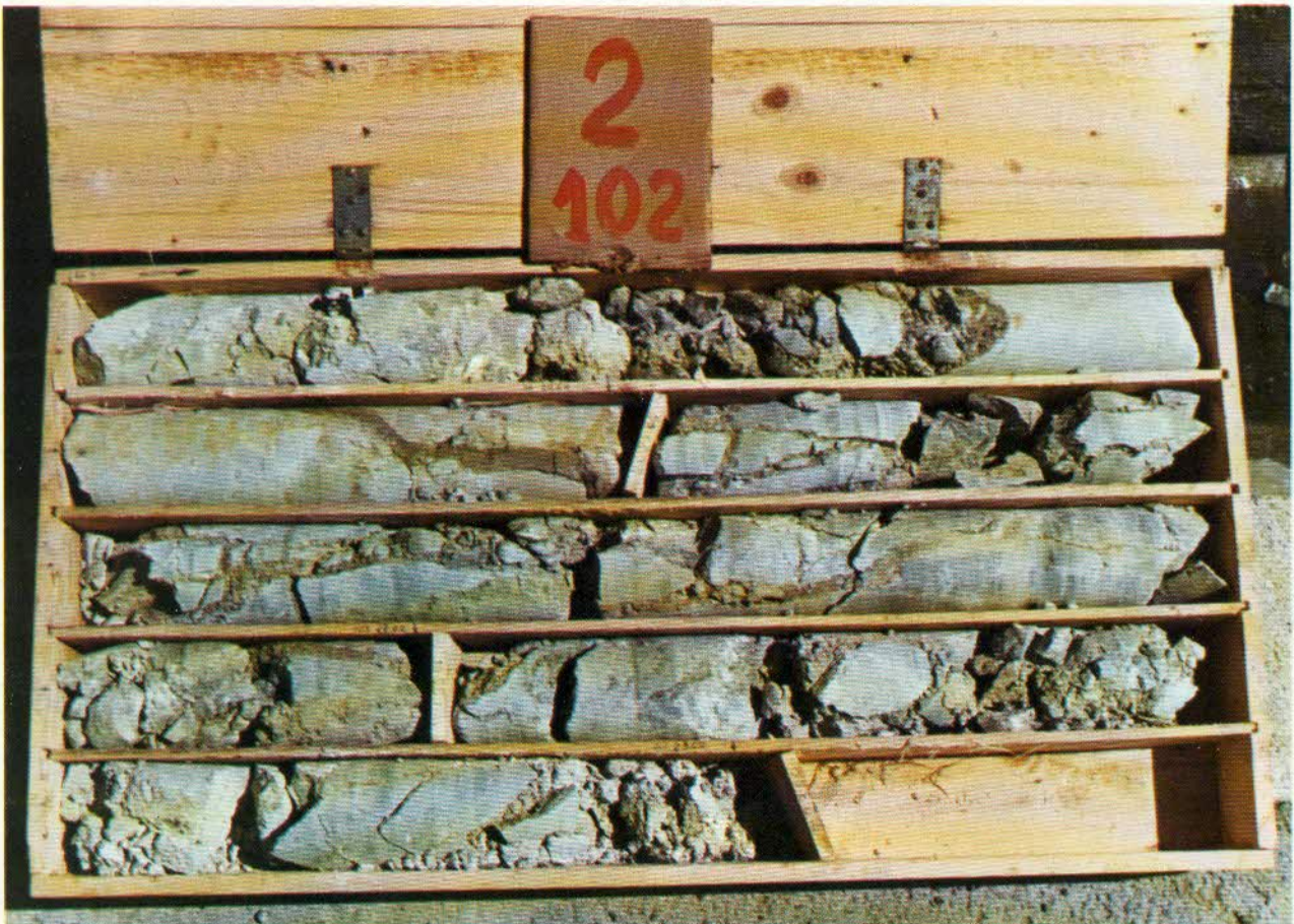
foto 7 - (sondaggio 102 cassa N. 2) Dalle carote si può notare l'estremo stato di degrado del calcare: le fessure della roccia sono riempite di materiale fine limoso.
